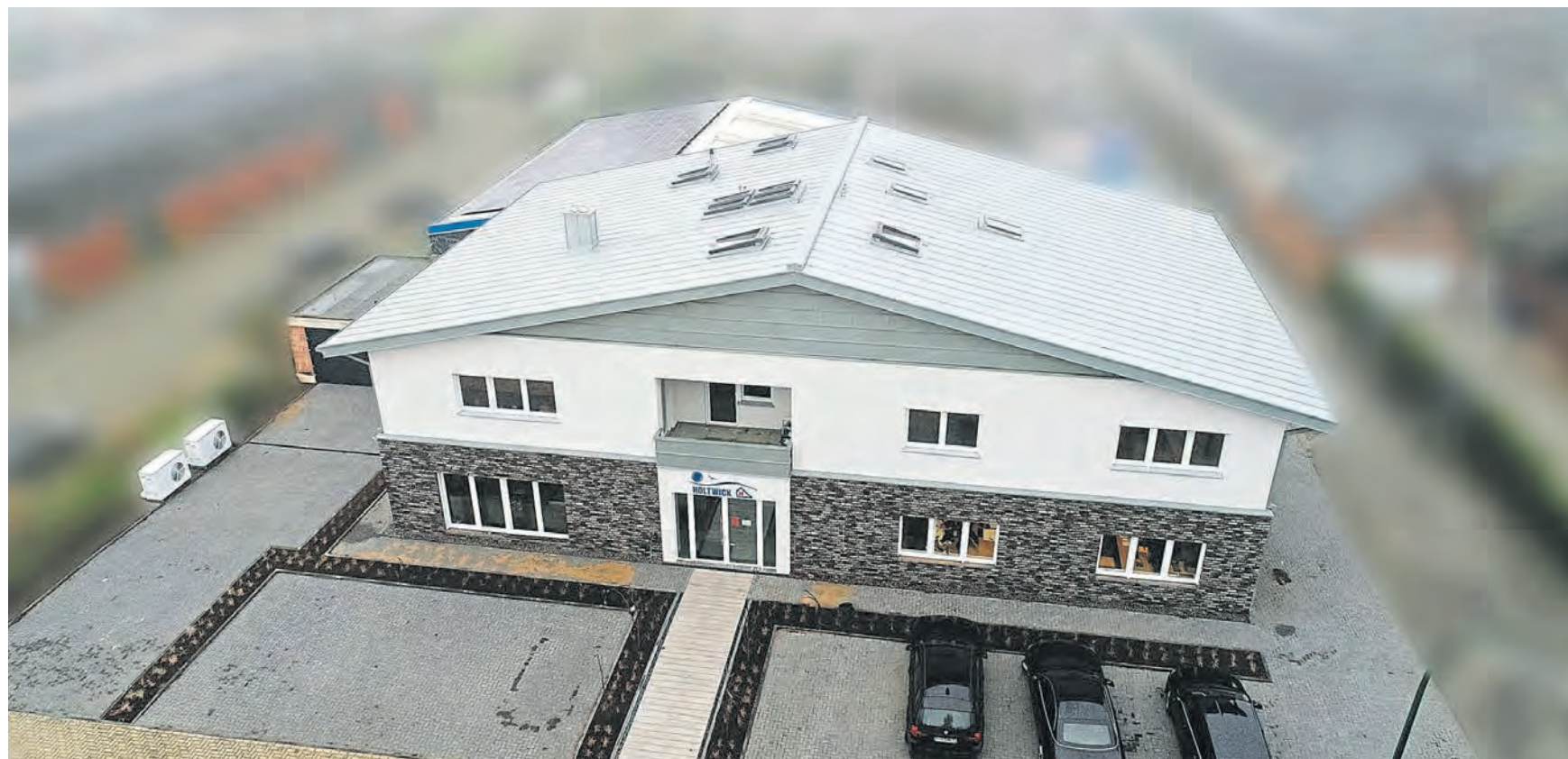
Spatenstich für die neuen Räumlichkeiten auf dem Betriebsgelände am Südring 16 war im Juni 2019.
